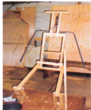
↑人形の基礎部分作成中
