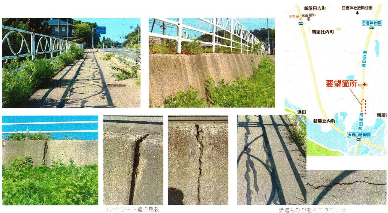
コンクリート壁の亀裂
