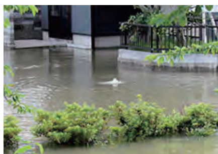
带状公園南側(マンホールからの噴出で水没)
