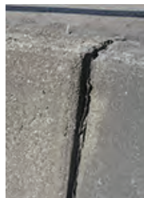
コンクリート壁の亀裂
