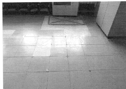
教室の床のタイルが割れたり、剥がれたり、波打ったりしている。写真は3教室だが、8～10教室は改善が必要。
