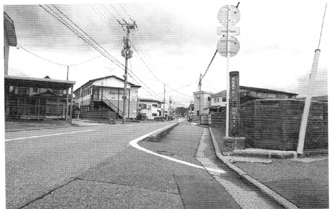
新屋駅前から県道56号線交差点に抜ける歩行者専用歩道の傾斜がひどく、特に高齢者のシルバーカー操作に支障をきたしている。
