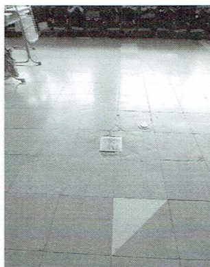
教室の床のタイルが割れたり、剥がれたり、波打ったりしている。写真は3教室だが、8～10教室は改善が必要。
