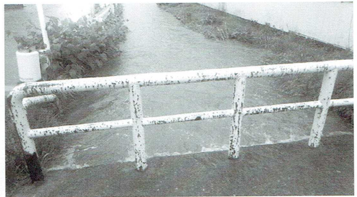
一昨年7月22日・23日の大雨時に続き、昨年5月18日にも南団地側の町内会会館付近の低地の雨水溝が溢れ出し、幹線排水路を跨ぐ橋梁から前野町側に流れ込んできた。
