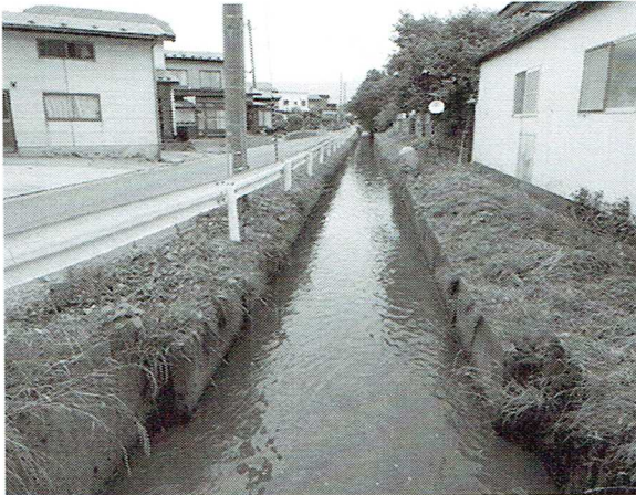
昨年5月18日の大雨警報発令時の排水路の状況。普段は水深10cm程度であるが、当日は60cmを超えた。
