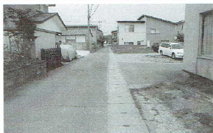
晴れている日の状態～道路中心部分
