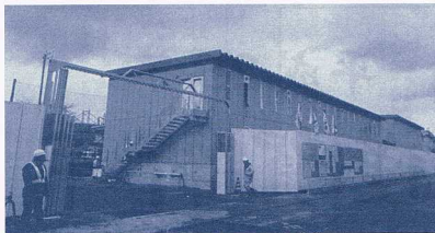
▲新築中の彫刻実習棟・サークル棟
