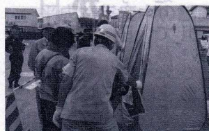
▲ウエスター仮説トイレの設置
