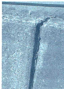
コンクリート壁の亀裂
