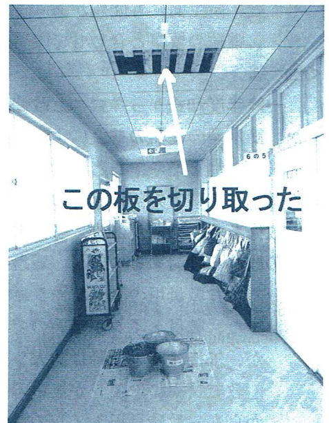
雨漏りがひどく天井をはずし、廊下にはバケツを置いた
