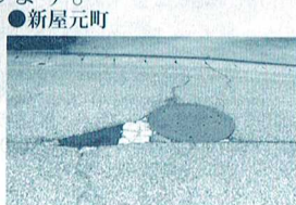
①新屋元町6-37前 ～道路のいたみとマンホール周辺のひび割れ
