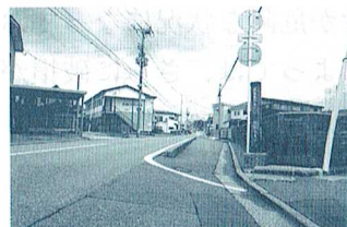
新屋駅前から県道56号線交差点に抜ける歩行者専用歩道の傾斜がひどく、特に高齢者のシルバーカー操作に支障をきたしている。
