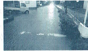
排水路の最終の集合管である「带状公園」地下のヒューム管が満杯となって、各排水溝の行き先が塞がれ、低地にある前野町の道路が冠水した。
