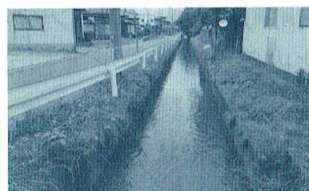
昨年5月18日の大雨警報発令時の排水路の状況。普段は水深10cm程度であるが、当日は60cmを超えた。
