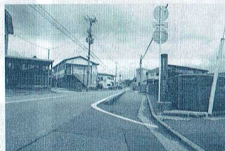
新屋駅前から県道56号線交差点に抜ける歩行者専用歩道の傾斜がひどく、特に高齢者のシルバーカー操作に支障をきたしている。
