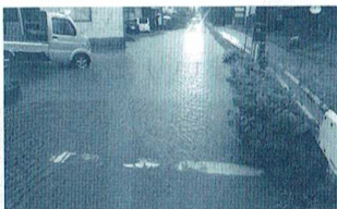
排水路の最終の集合管である「帯状公園」地下のヒューム管が満杯となって、各排水溝の行き先が塞がれ、低地にある前野町の道路が冠水した。
