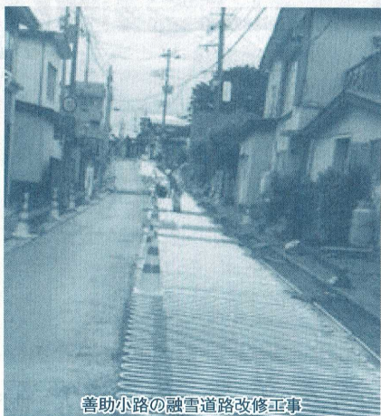
善助小路の融雪道路改修工事
