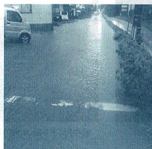
排水路の最終の集合管である「带状公園」地下のヒューム管が満杯となって、各排水溝の行き先が塞がれ、低地にある前野町の道路が冠水した。
