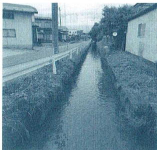
昨年5月18日の大雨警報発令時の排水路の状況。普段は水深10cm程度であるが、当日は60cmを超えた。
