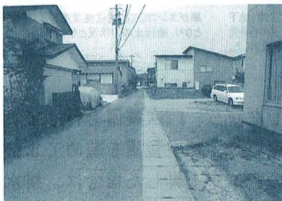
晴れている日の状態～道路中心部分
