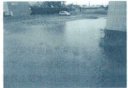
左の写真の角度が違う写真～道路中心部分
