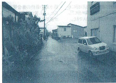
集中的に雨が降った時の状態～道路中心部分
