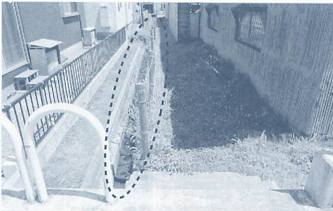
西部市民サービスセンター駐車場側から
