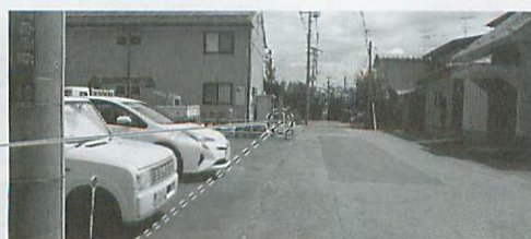
西側から見る。塀は境界まで下がっている。(2023. 8.4撮影・手前の土地は工事中)
