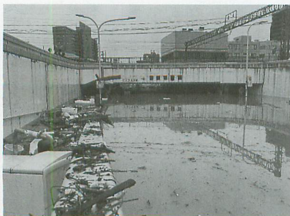
7月豪雨により冠水した明田地下道
