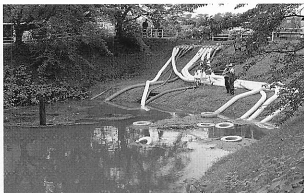
带状公園が水没したため非常時排水を早期に対応
