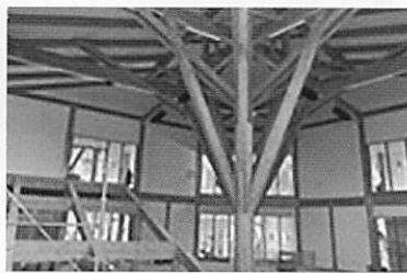
図書館の吹き抜け
