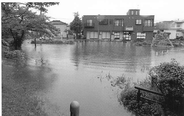
2023年7月15日、豪雨で带状公園の散歩道が水没し、扇町の途中まで浸水
