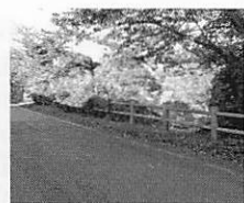
⑮倒れてきている、破損している
