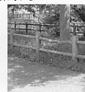
⑱破損している
