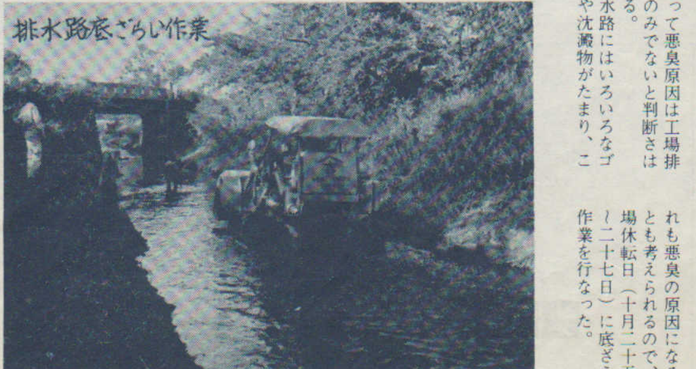
排水路底ごらい作業
