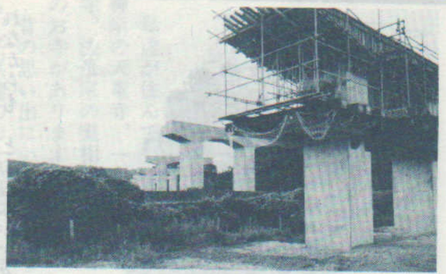
県道新屋豊岩線の工事
