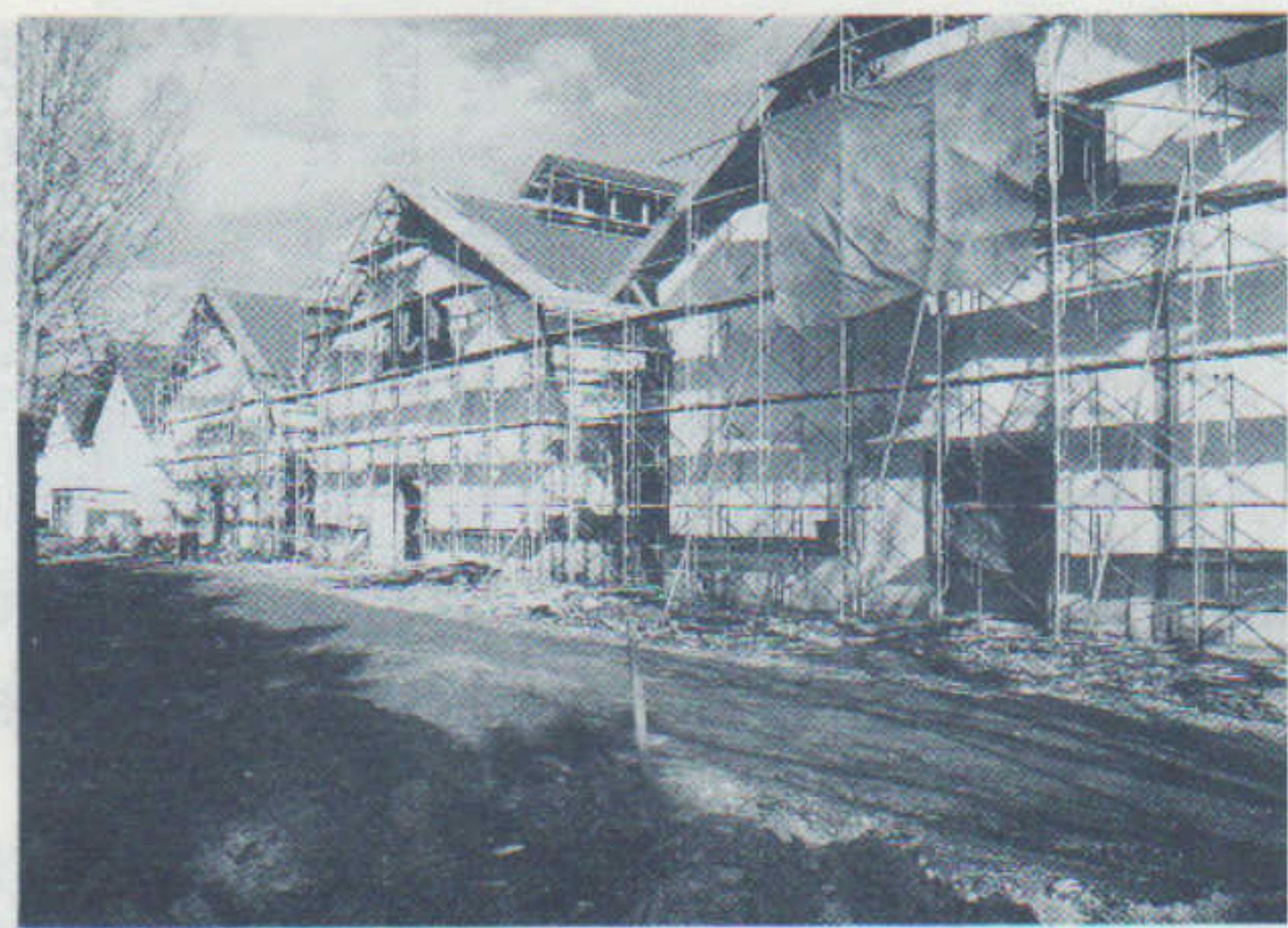
平成8年度より供用開始となる旧国立倉庫(4号～6号棟)
