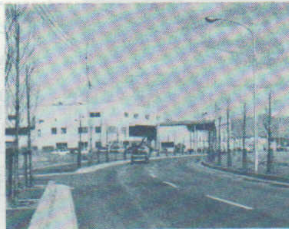
順調に整備が進み操業開始が待たれる西部工業団地
